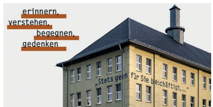
Das ehemalige Verwaltungsgebäude der Firma Bilder(2): Stadt Erfurt / Dirk Urban
